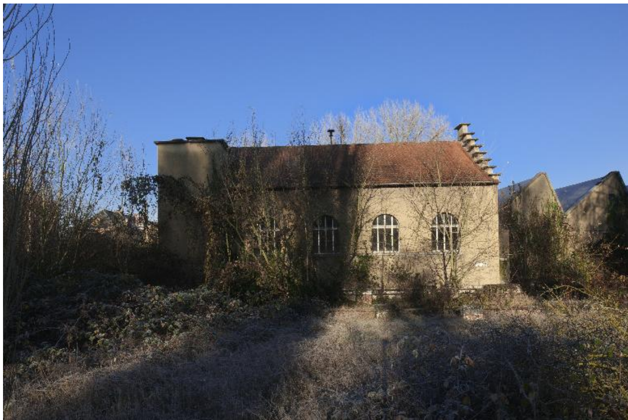
Façade latérale sud du transformateur électrique.
