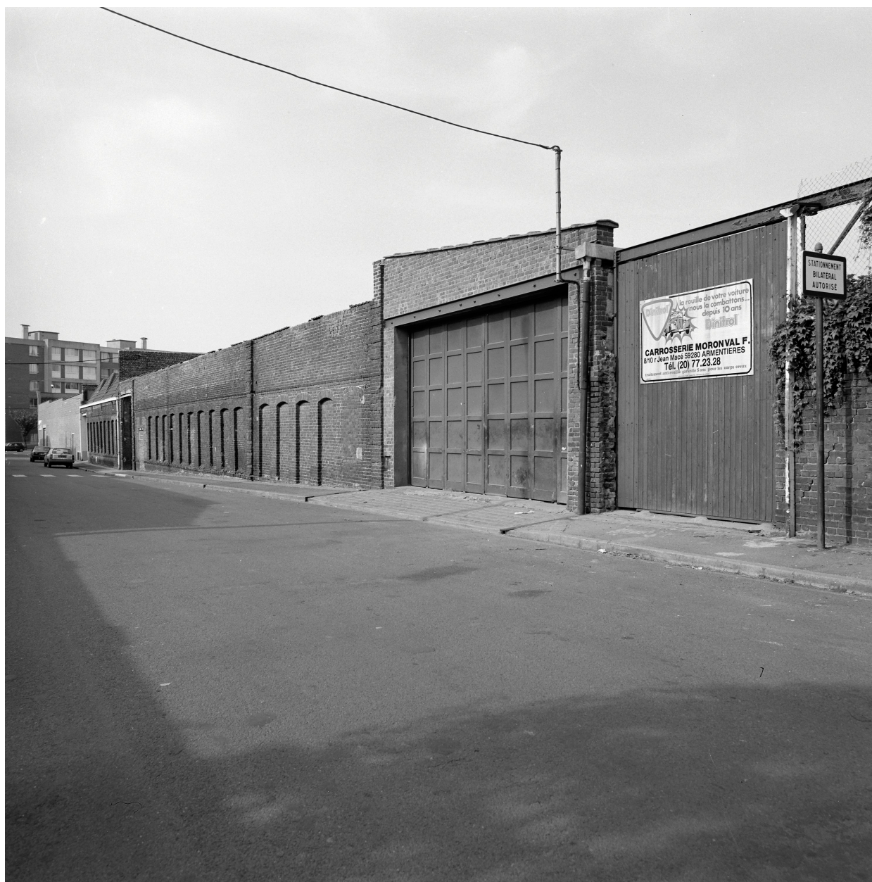
Élévation rue de Metz. Vue prise vers le Nord.
