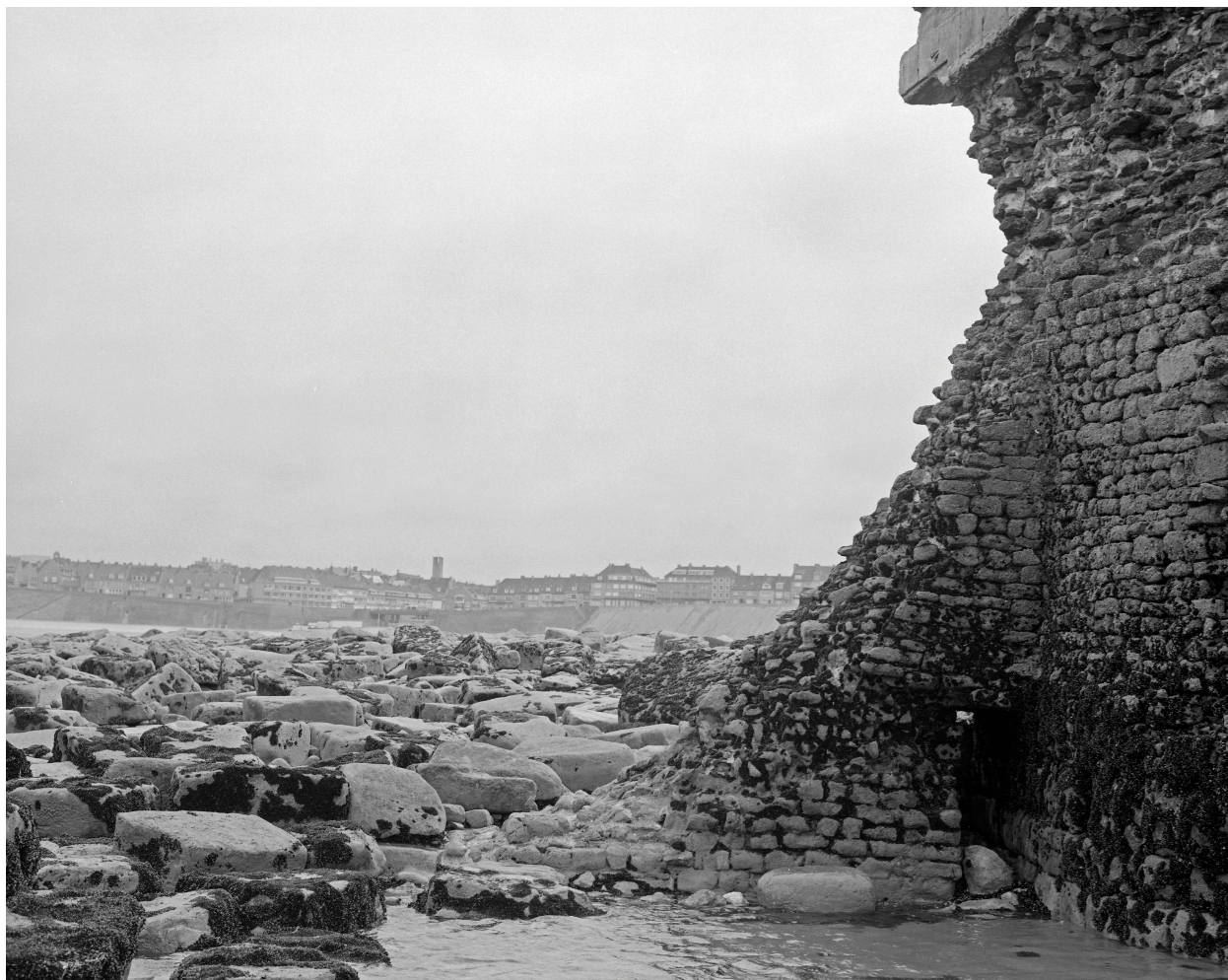
Angle sud : détail.
