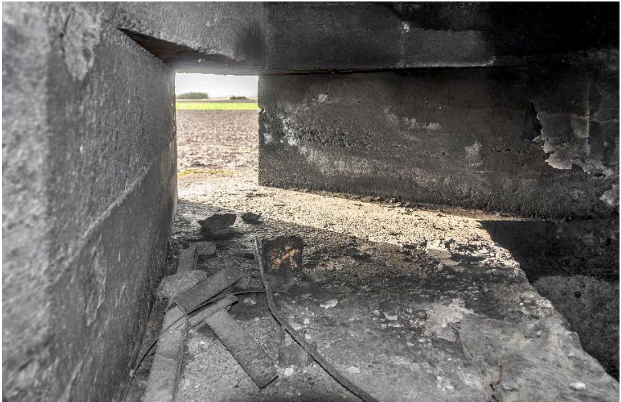
Vue intérieure de la banquette de tir et de l'embrasure sud-ouest de l'édifice.
