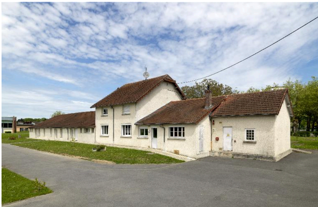
Vue générale depuis le sud-ouest.
