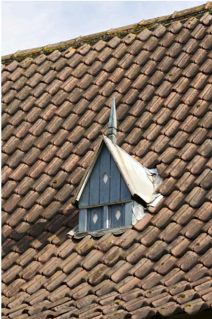
Détail d'une lucarne d'une ferme de Rubrouck.
