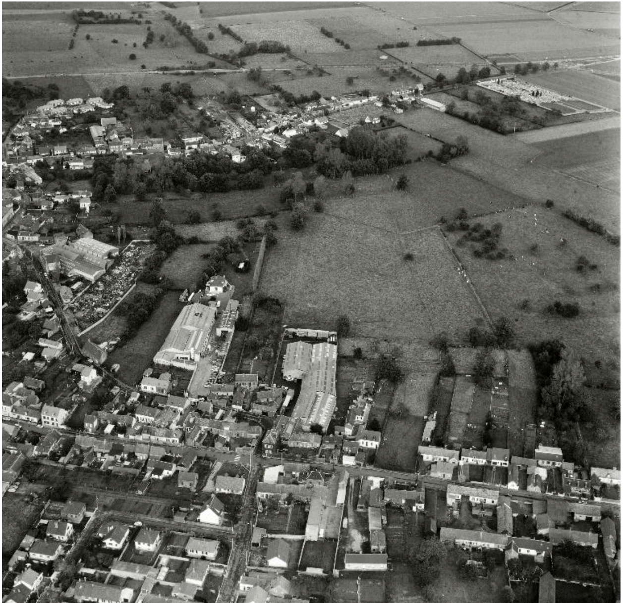
Vue aérienne de l'usine en 1988.
