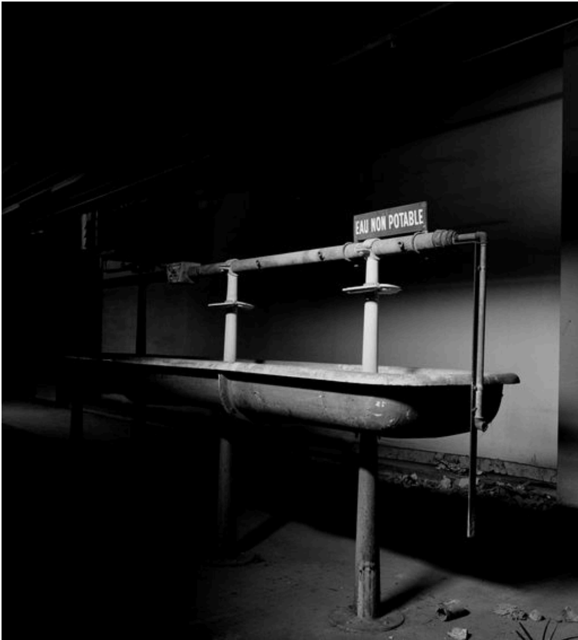
Ensemble de lavabos des anciens sanitaires.
