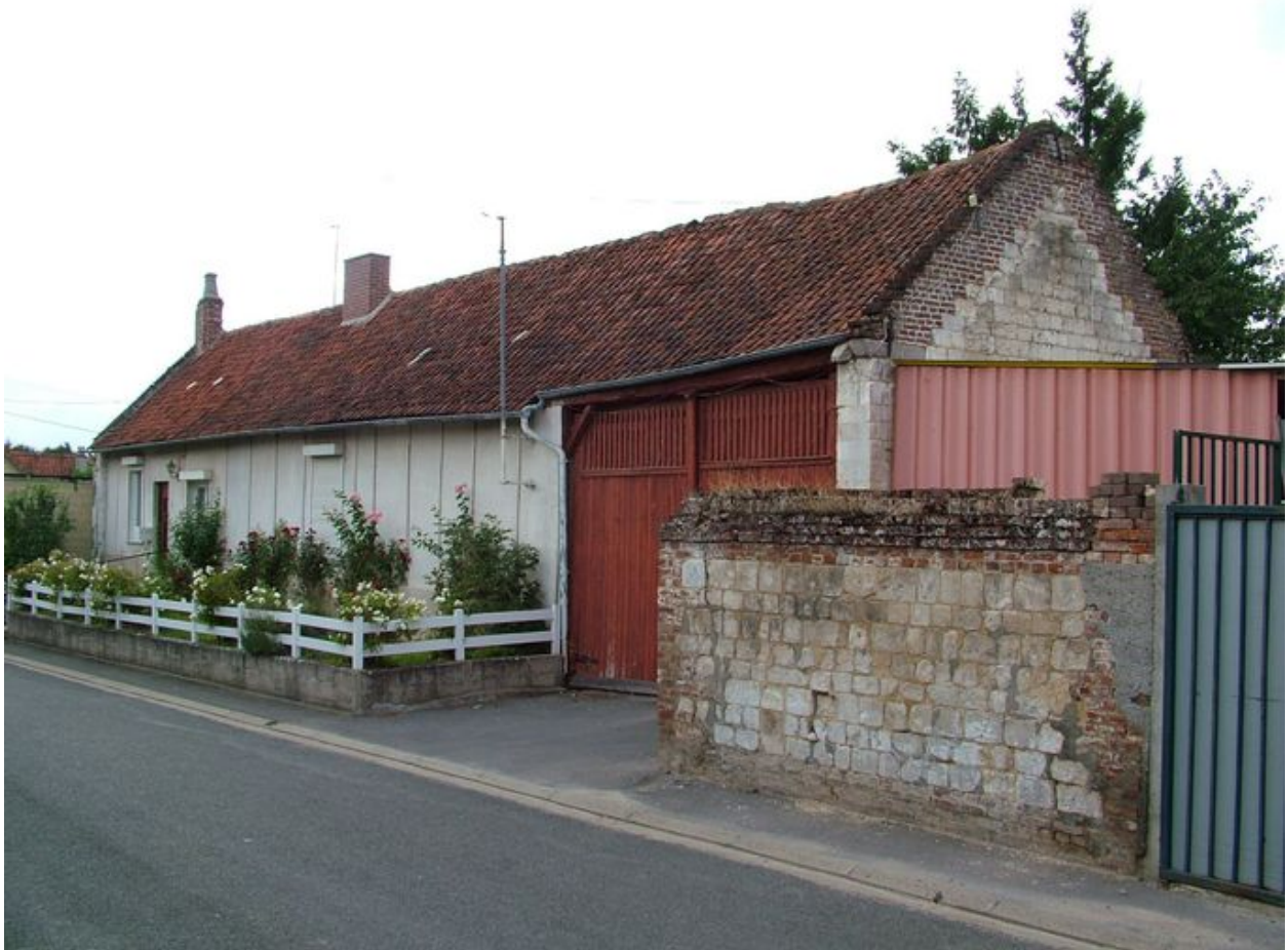
Maison, 287 rue d'En-Bas, 1er quart 19e siècle.
