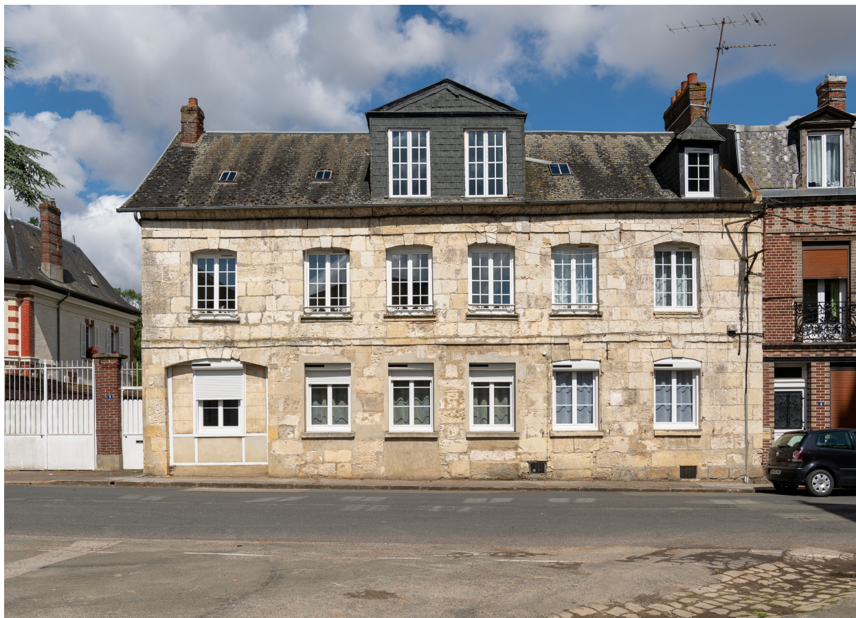
Demeure en pierre, n°3 de la Place de la Mairie, vue depuis le sud.
