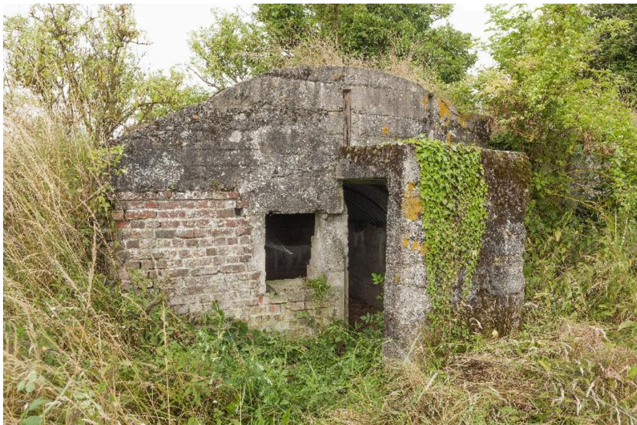
La casemate b et son entrée pare-souffle
