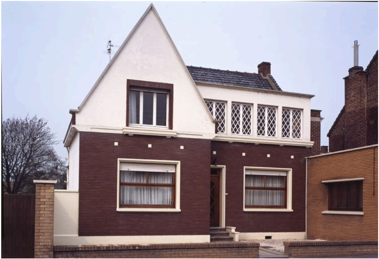
Pavillon des années 1970, 72 rue du Moulin.
