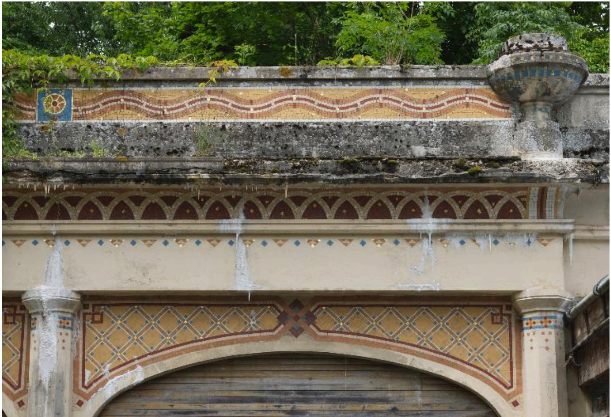
Détail du revêtement de mosaïque du garage.
