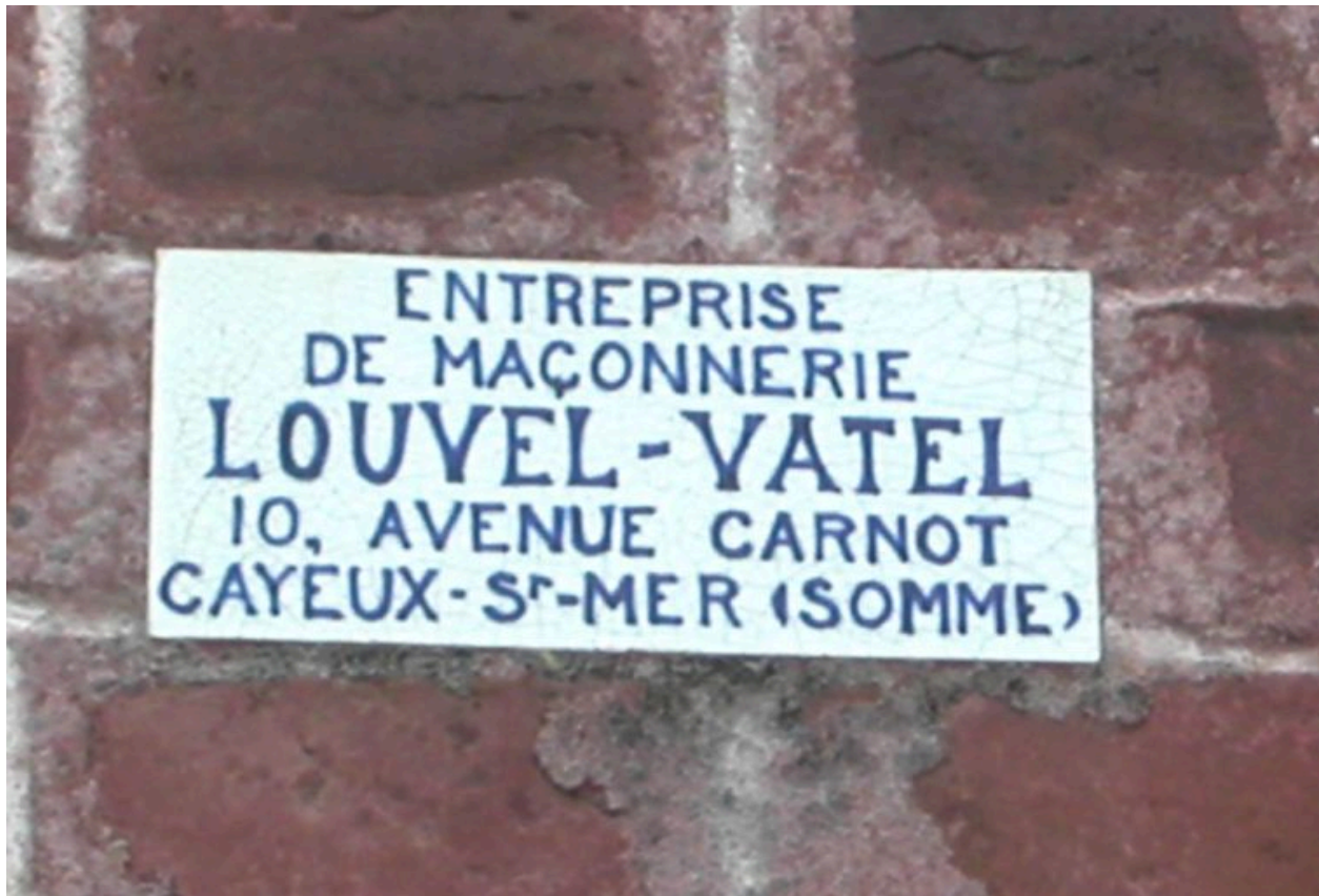
Carreau de céramique portant signature du maître d'oeuvre (Louvel-Vatel).
