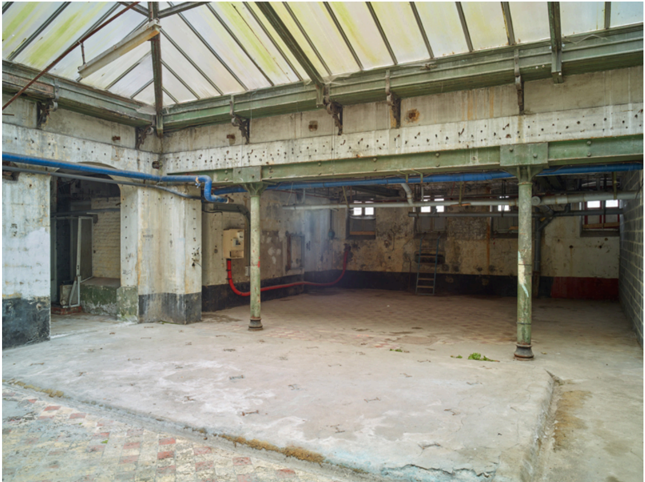
Aile sud, sous-sol. Vue générale de la lingerie depuis la cour vitrée.
