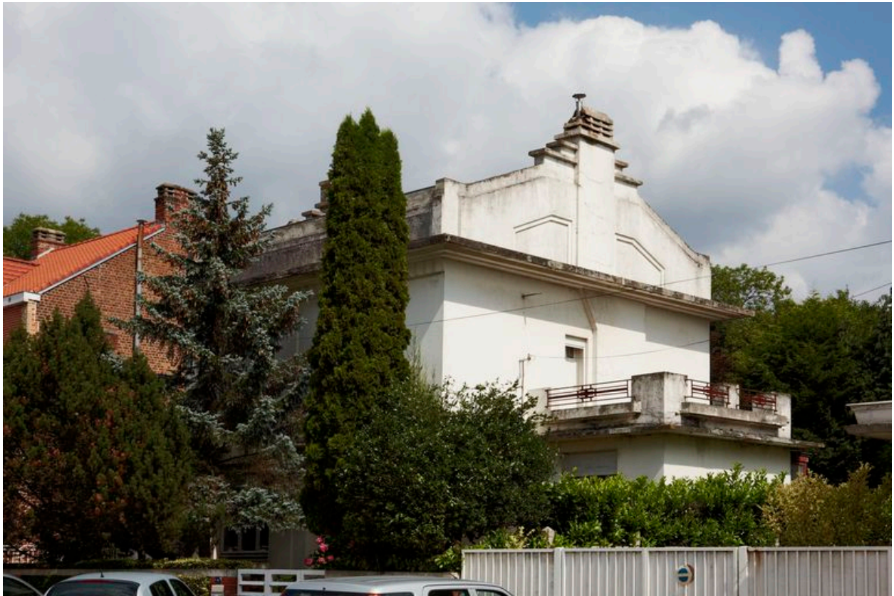
Façade latérale, vue partielle : traitement du pignon.
