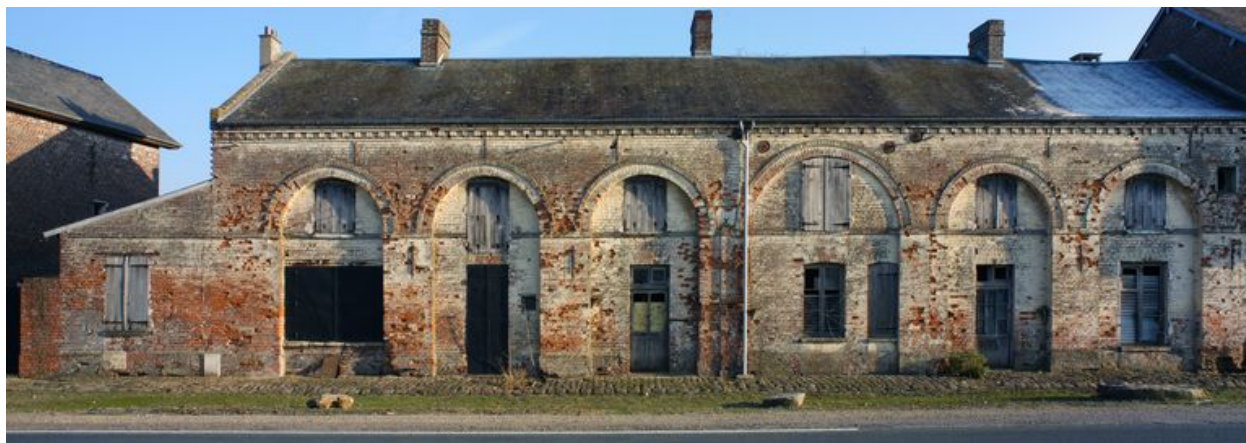
Façade sur rue des logements ouvriers construits au milieu du 19e siècle.
