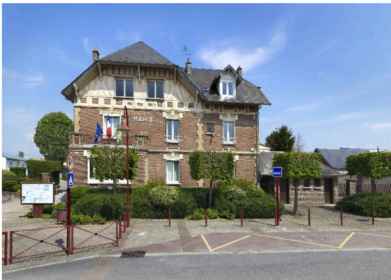
Vue générale, façade sur rue.
