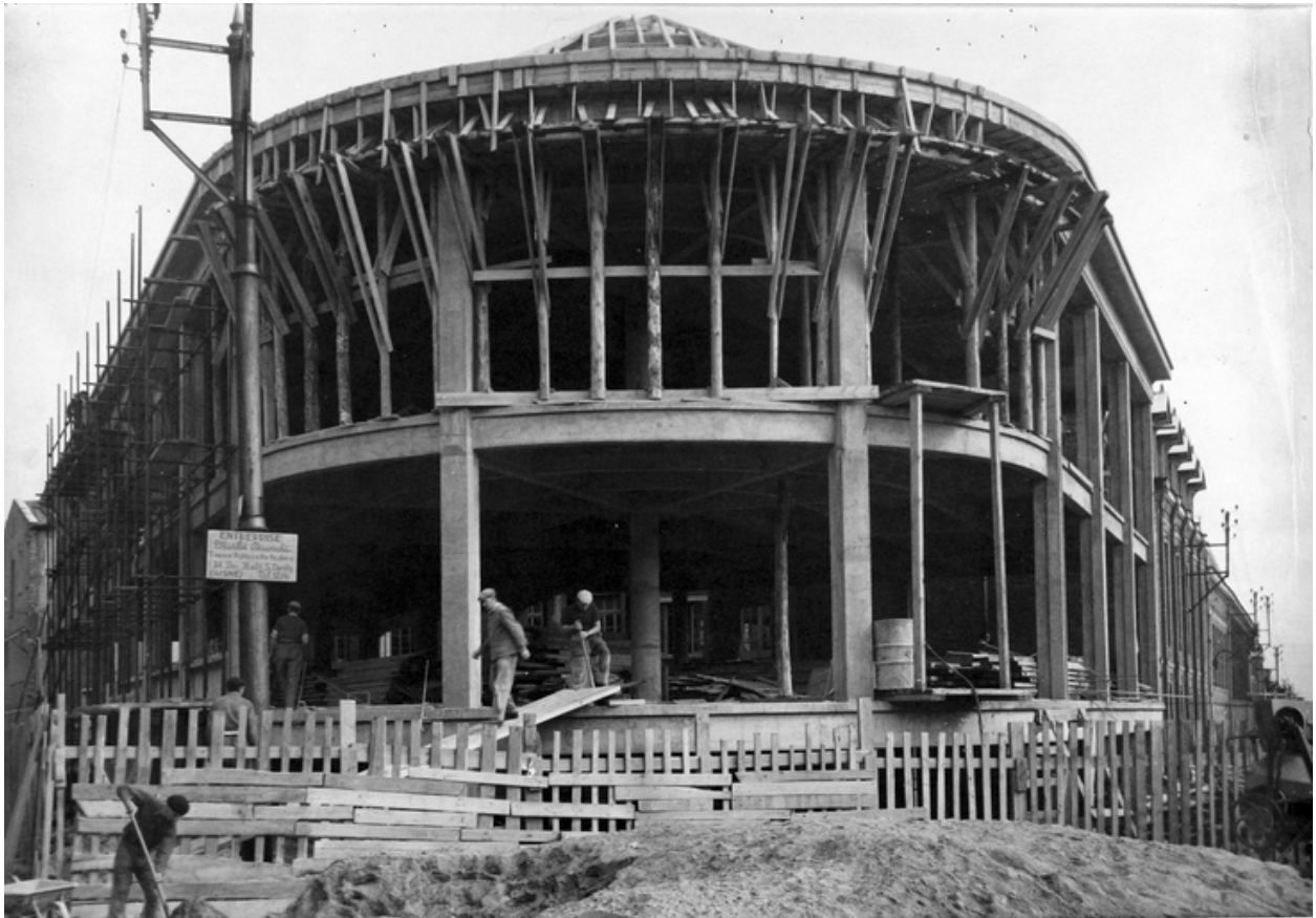
Chantier de construction des ateliers, par Desprey-Pollet, vers 1948 (IFA).
