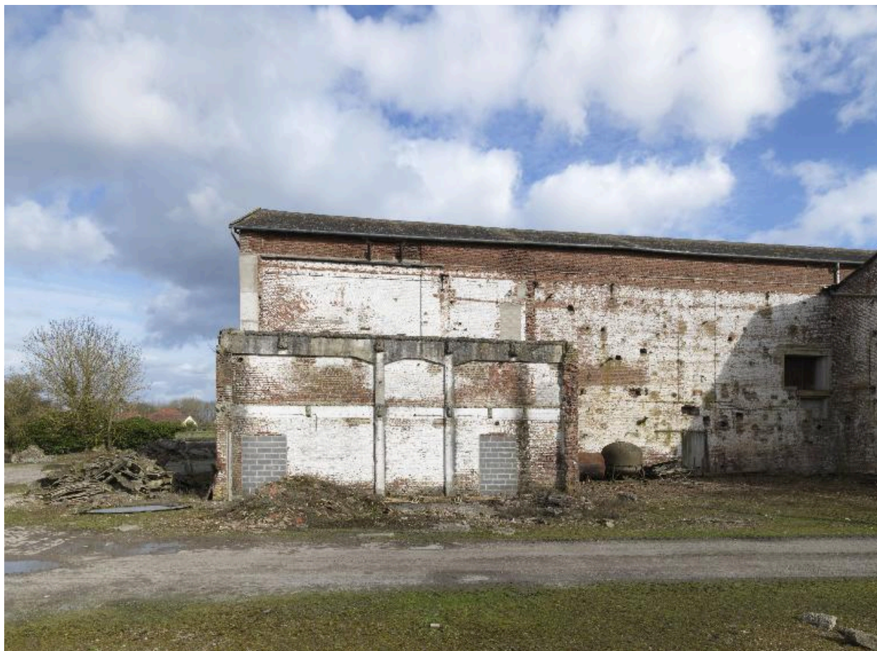
Atelier de fabrication, détail de l'élévation du côté nord.
