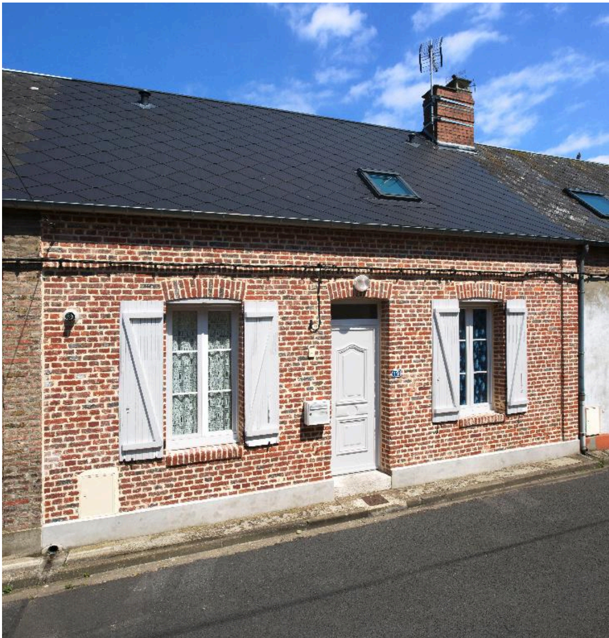
Vue d'un logement, n°19 de la cité Hurtel.
