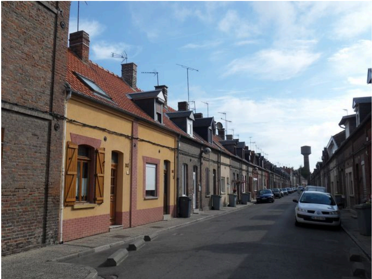
Vue des logements, rue Docteur-Jean-Martin (rive nord).
