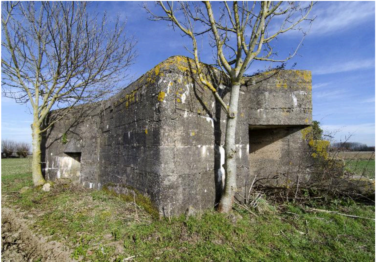
Vue générale vers le nord (au grand angulaire). A gauche l'entrée ouest, à droite l'entrée sud et l'accès au poste de mitrailleuse
