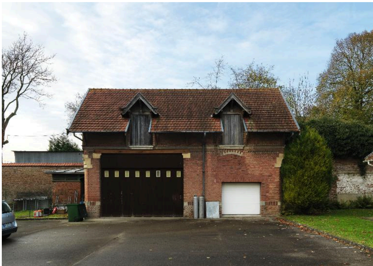
Façade sur cour du bûcher et de la la remise de la Prévoyance.
