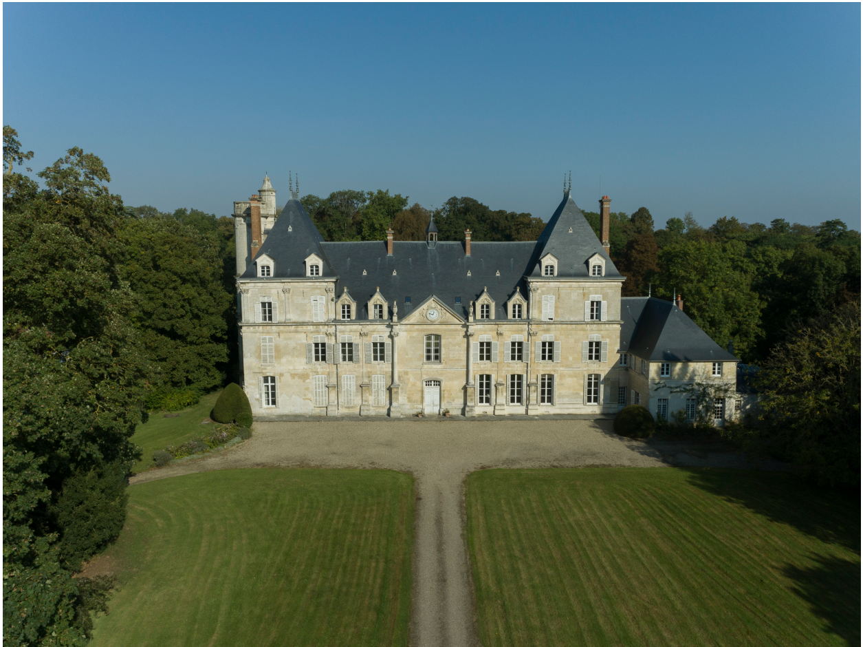
Vue aérienne dans l'axe de l'allée principale.
