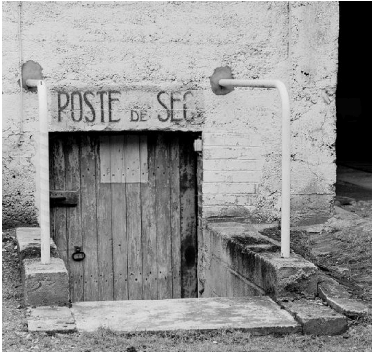
Entrée du poste de secours.
