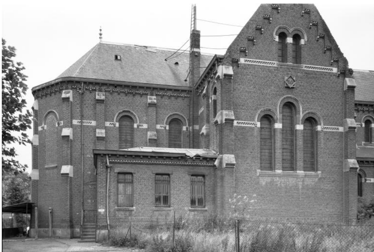
Vue du chœur et du transept, vers le sud.
