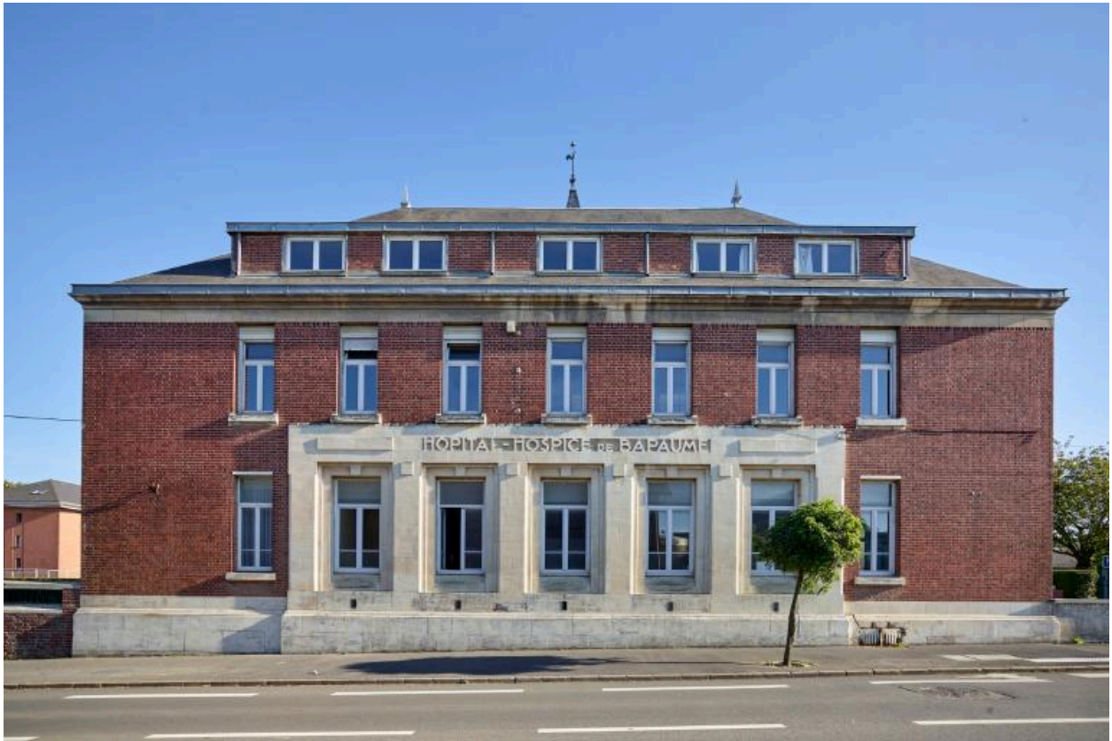
Ancien pavillon de l'administration : façade sur la rue de la République.
