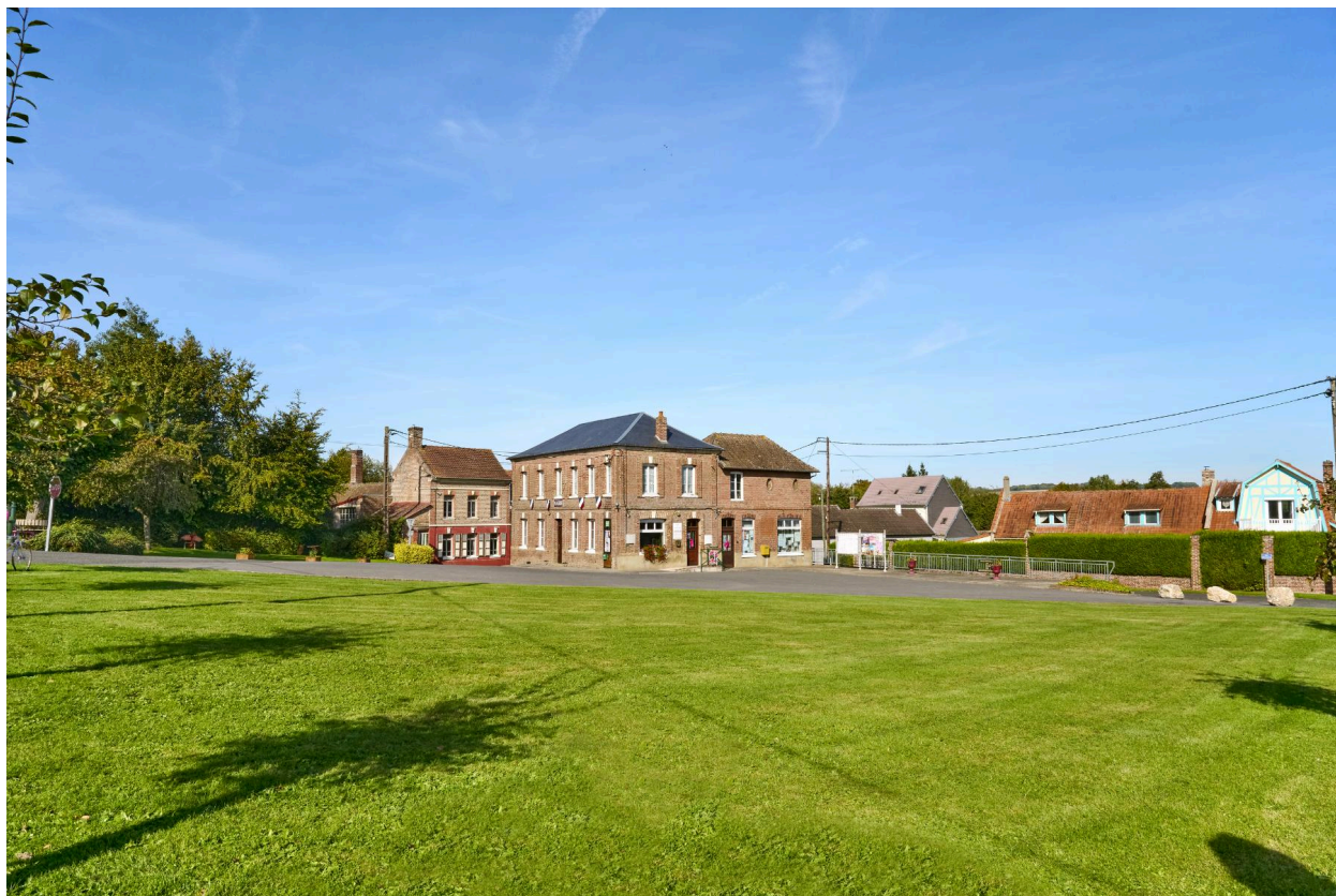
Vue sud-est de la mairie et de la place Jeanne-de-Fontaine.
