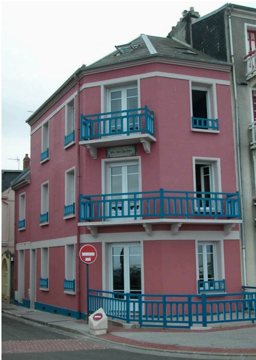
Vue d'ensemble depuis l'esplanade.
