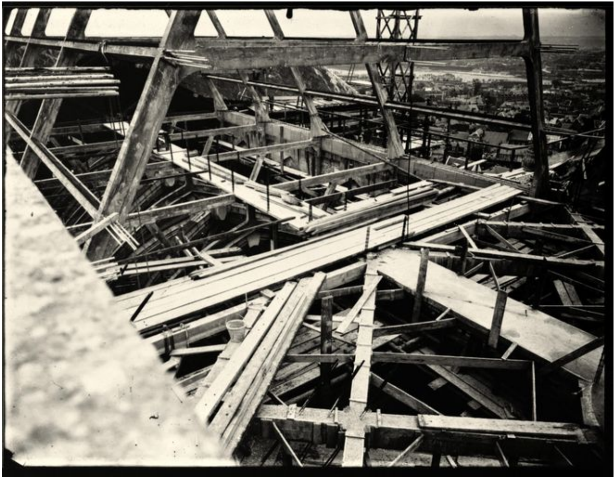
Pose de la charpente du vaisseau central (photographie de l'entre-deux-guerres).
