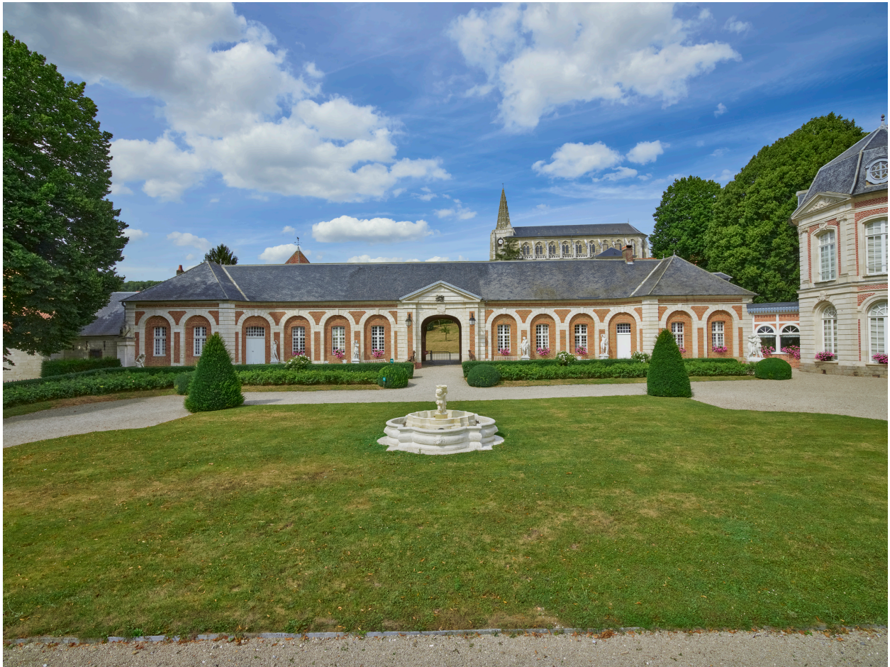
Façade sud des communs du château.
