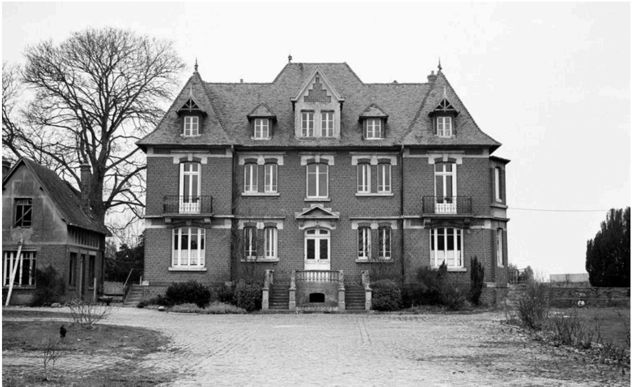
Façade antérieure, sur cour.
