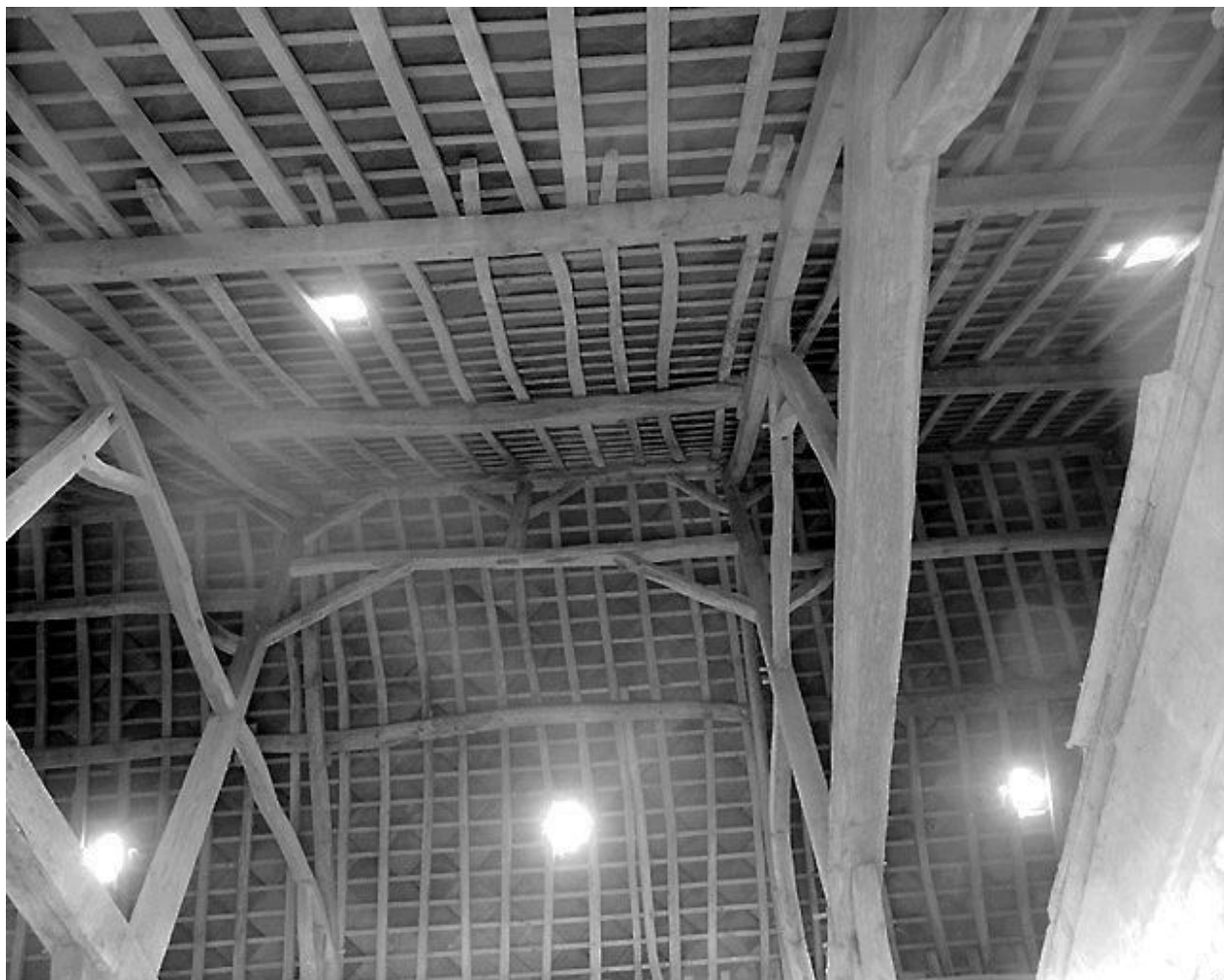
Charpente de la grange.
