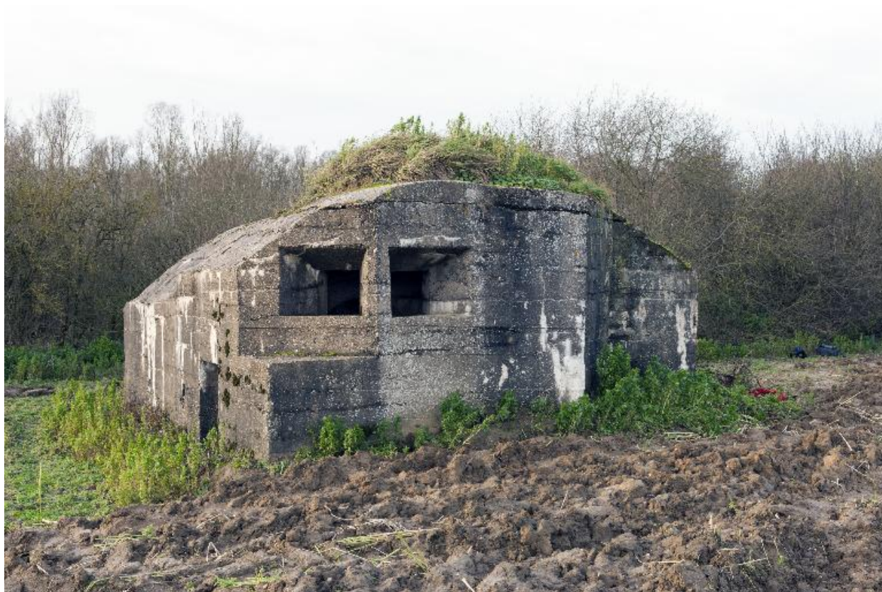
Vue de trois-quarts vers le nord-ouest
