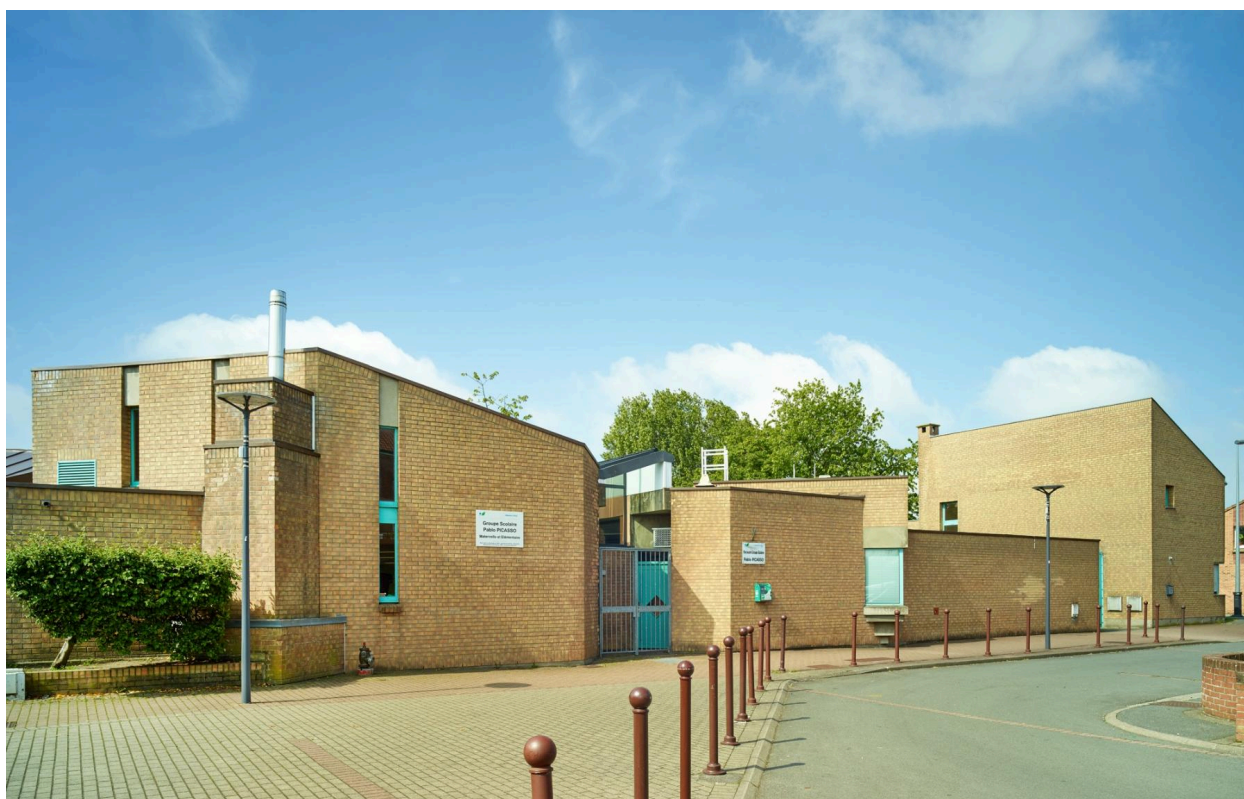
L'entrée du groupe scolaire, sur la place aménagée rue du Pavé-Bleu.
