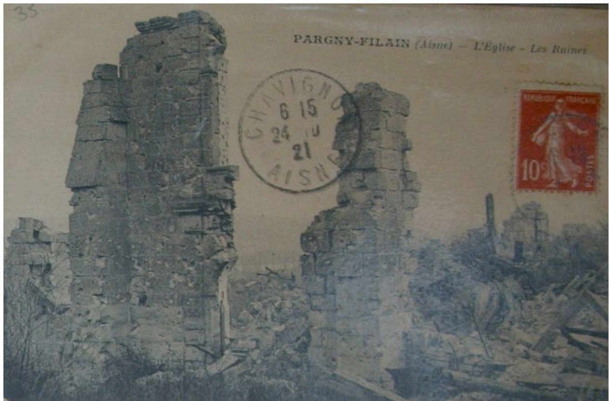
Vue de l'église en ruine (coll. part).
