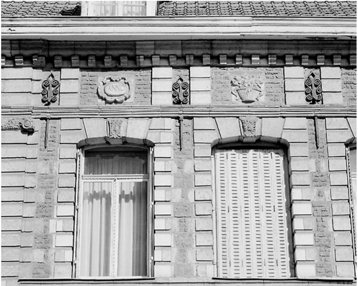
Façade rue Notre-Dame, détail : travées 5 et 6 en partant de la gauche, étage.
