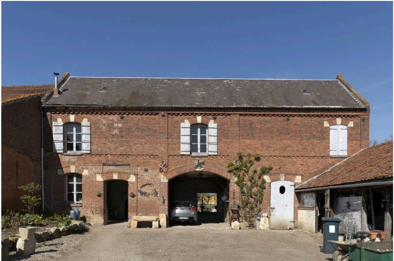
Ancien relais à chevaux (avec écuries au rez-de-chaussée) puis salle communale (1er étage), n°48 rue Principale, vue depuis l'est.
