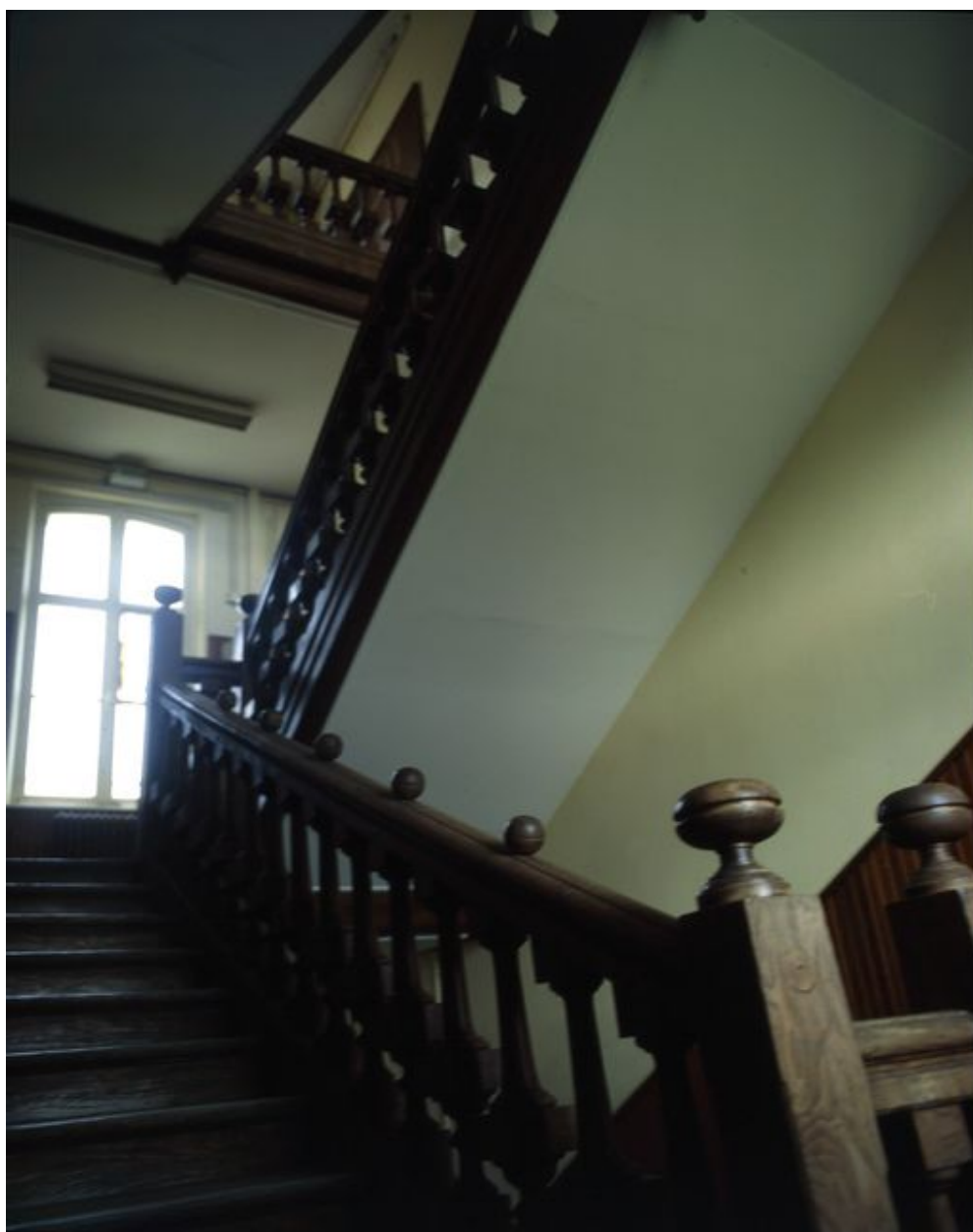
Escalier de distribution intérieur.
