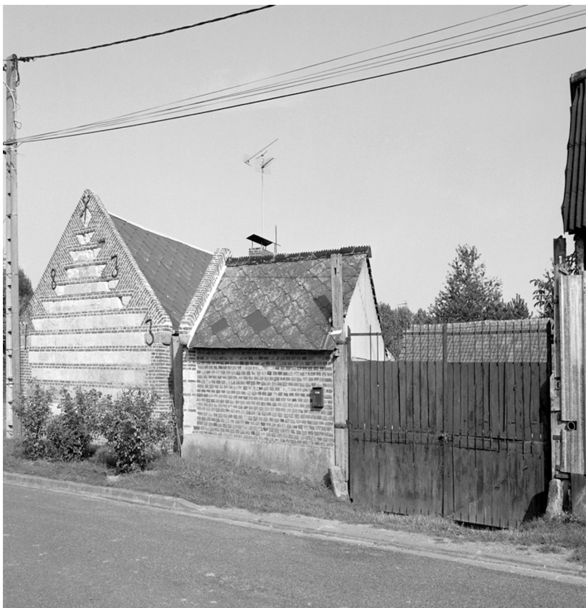
Fréchencourt, ferme, 8 rue Haute.
