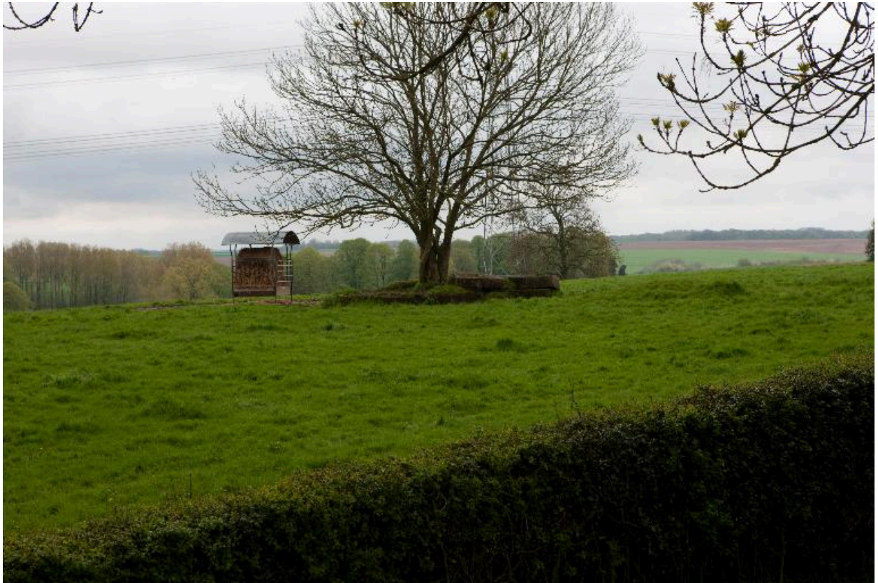
Bunker de tir hexagonal.
