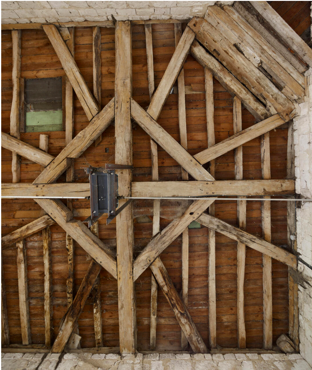
Intérieur de la charpente.
