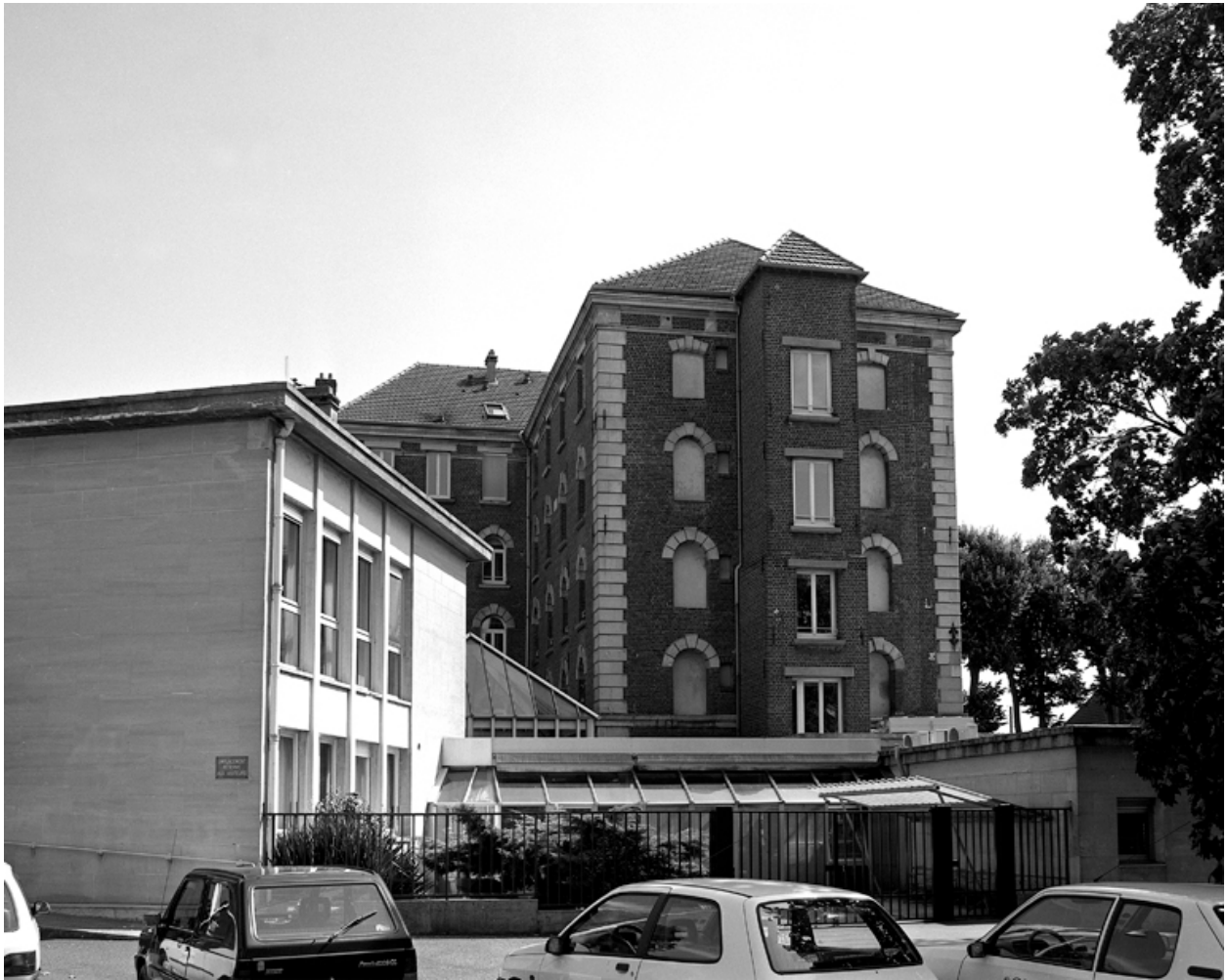
Vue antérieure ouest.
