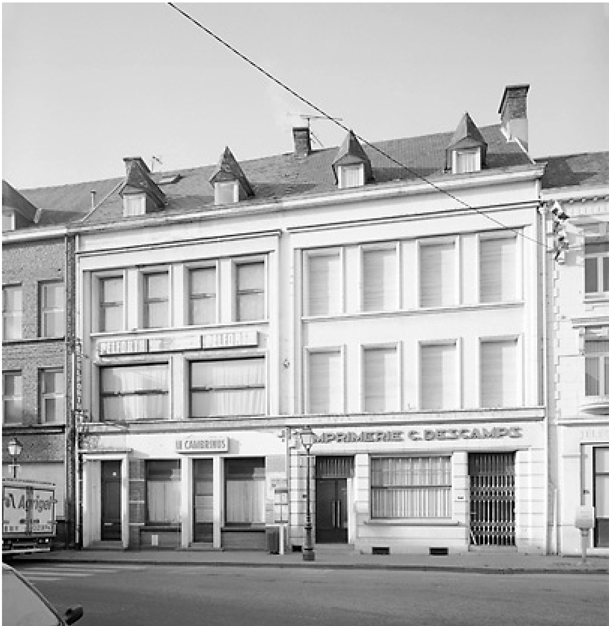
Maisons n° 38 et 34-36, vue générale (état en 2001).
