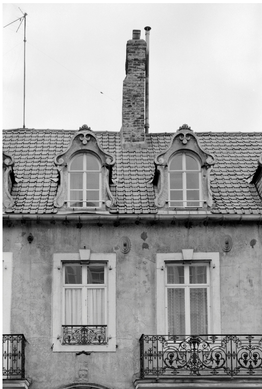
Façade sur voie, fenêtres, lucarnes.
