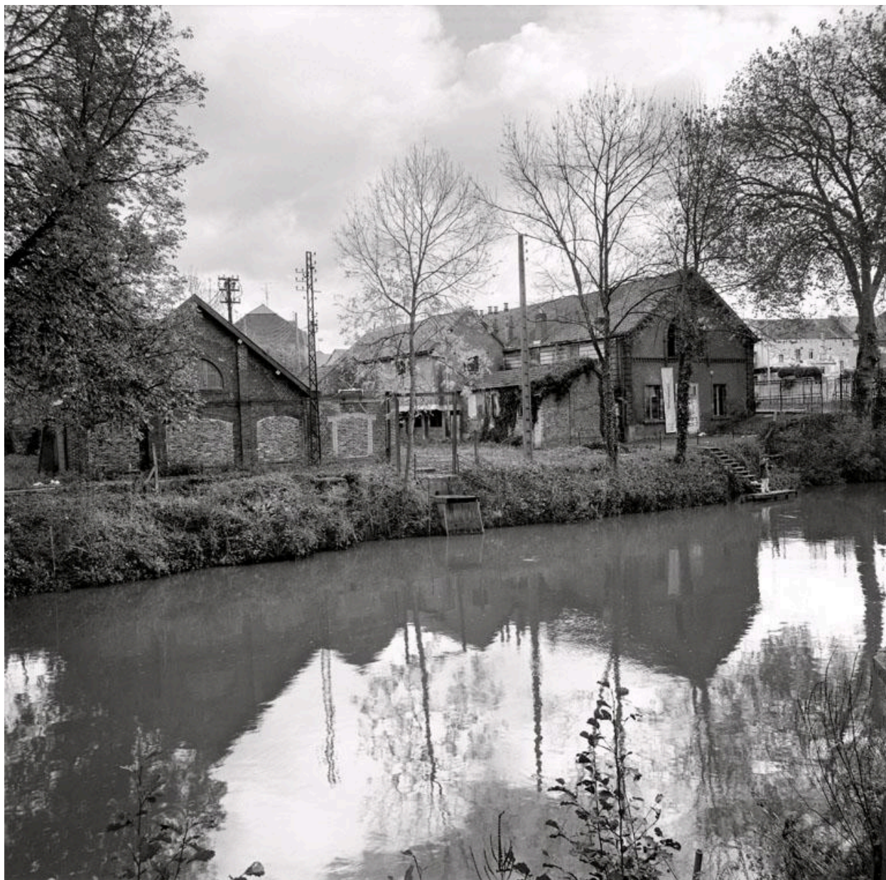
Vue générale, depuis l'Oise, des bâtiments.
