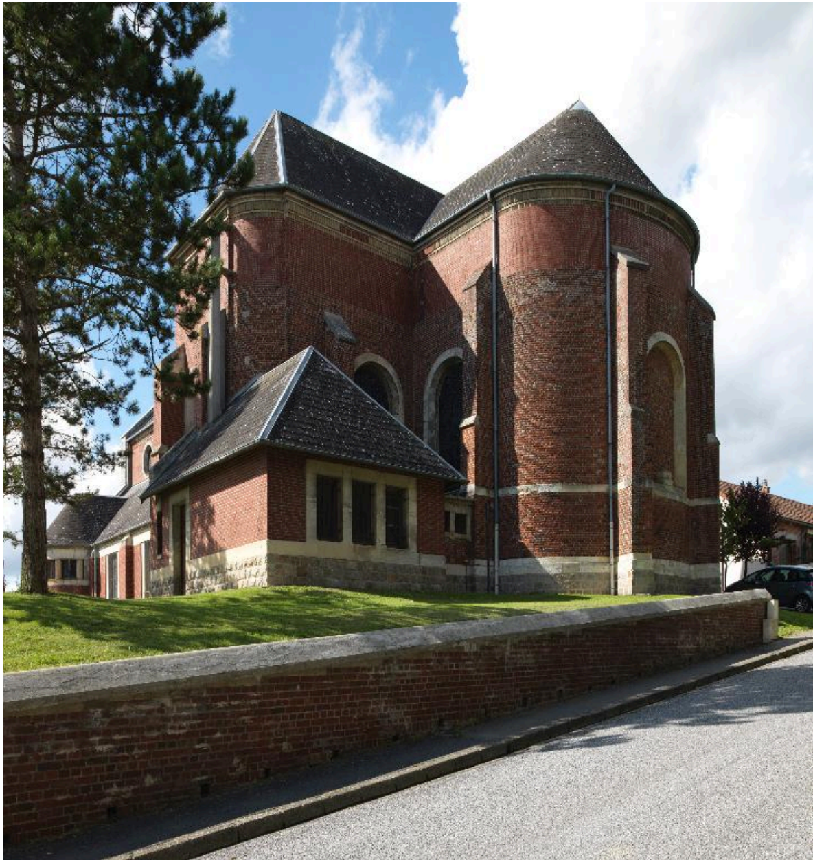
Vue du chevet, depuis la rue Paul-Lassalle.
