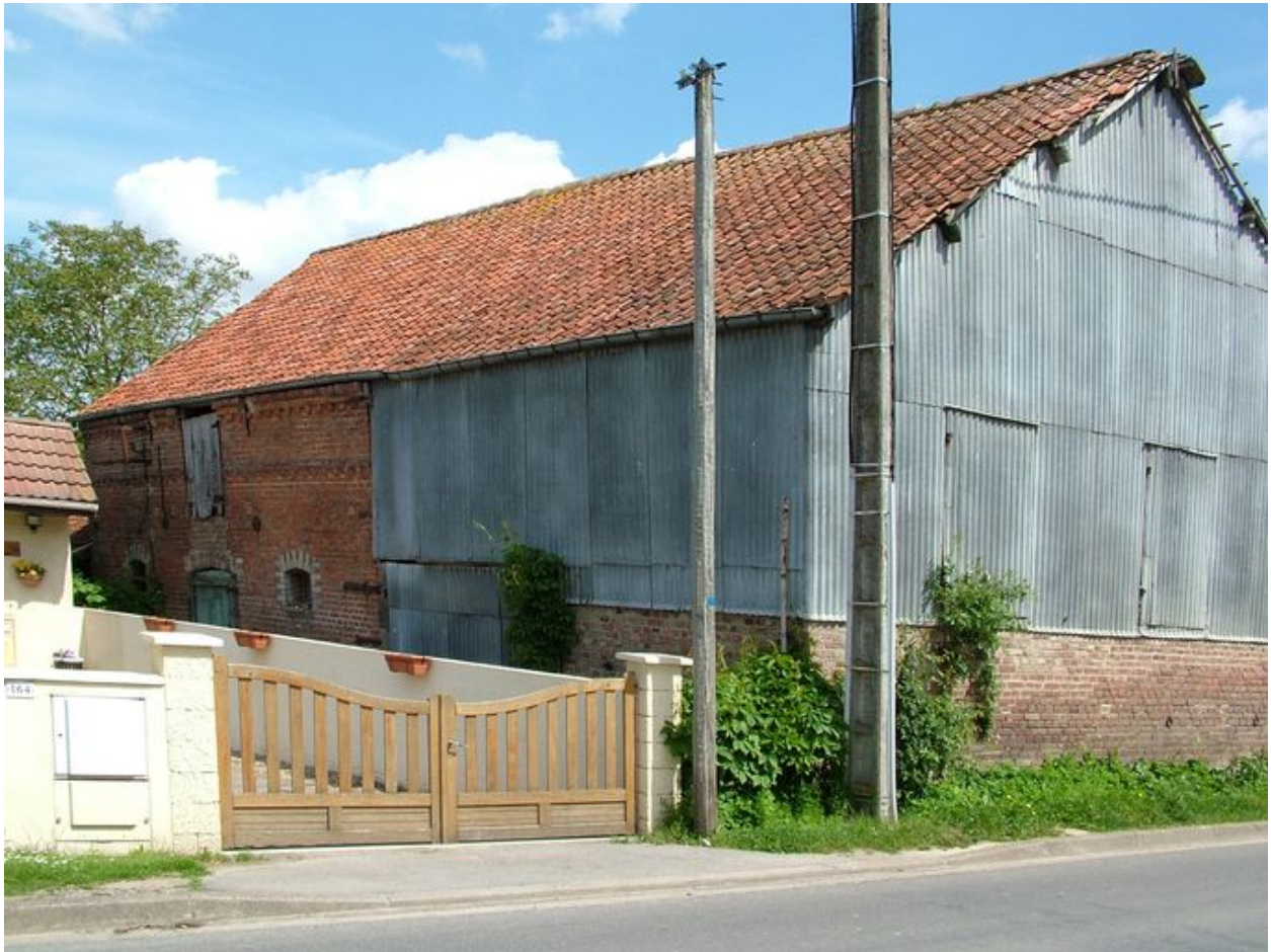
Vue arrière de la grange.
