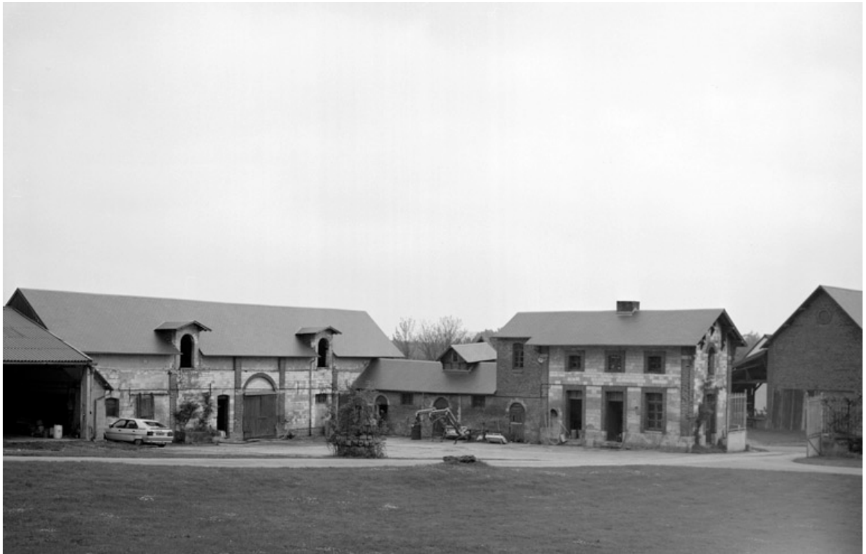
Partie septentrionale des communs : écurie et logement du fermier, depuis le château.
